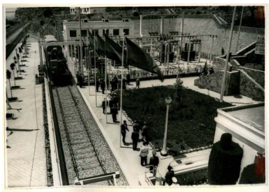
Estació de Garraf, aspecte general de la subestació el dia 26 de juny de 1956, inauguració de l'electrificació Barcelona-Tarragona.
