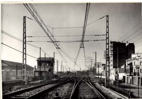
Vista de la Bifurcació Bordeta, en direcció a Prat, després de l'electrificació.
