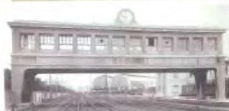
Mesa de enclavamientos de la estación de Francia, de 1924. Arriba el Puesto Central de Enclavamientos y Señales (PCES), dentro del cual se encontraba la mesa (al fondo de la imagen se observa la marquesina curvada de la estación).
