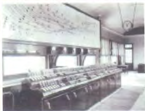
Mesa de enclavamientos de la estación de Francia, de 1924. Arriba el Puesto Central de Enclavamientos y Señales (PCES), dentro del cual se encontraba la mesa (al fondo de la imagen se observa la marquesina curvada de la estación).
