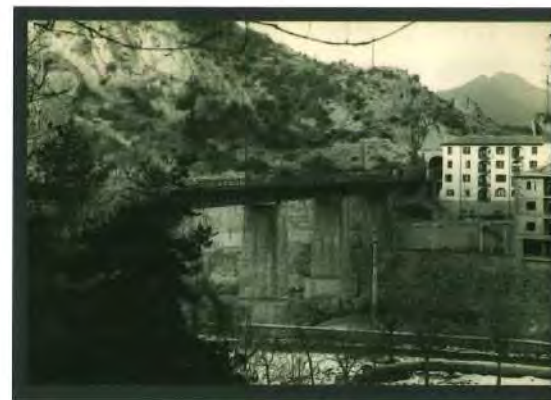
Viaducte de la Fondalada, al Garraf (1881) i pont amb biga d'ànima plena sobre el Ter, a la localitat de La Farga (Francesc Ribera Colomer, mitjà segle XX).
