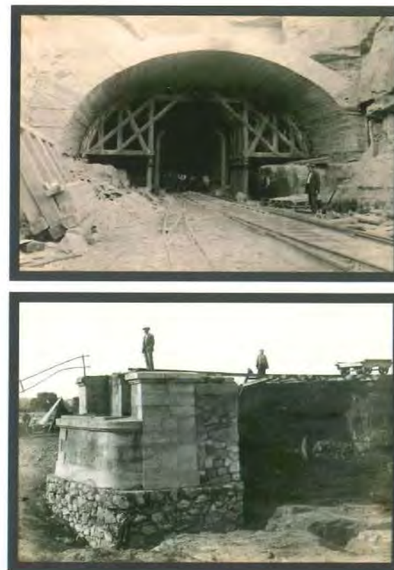
Construcció de túnel (anònim) i reconstrucció de pont (Ribas y Pradell) a final segle XIX.
