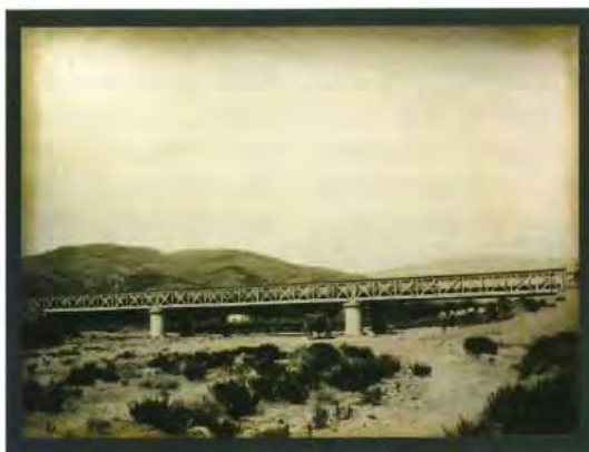
Viaducte de Olesa (Francesc Ribera Colomer, 1954) i pont de la Riera de Borges, amb biga de gelosia en forma de Creu de Sant Andreu (Andonard y C a , 1890).
