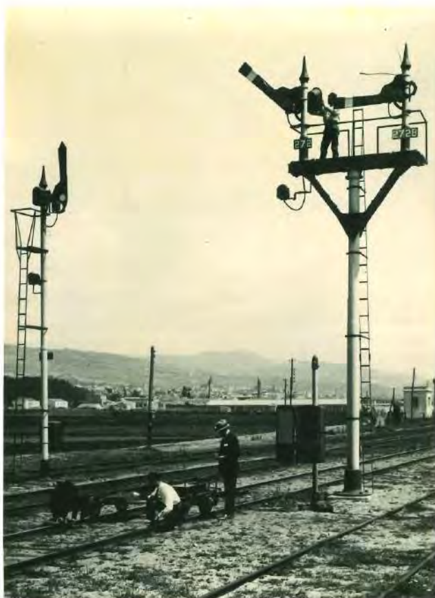
29. Jaume Ribera Llopis, 1924. 12 x 18 cm. Instal·lació de senyals d'entrada i sortida de la General Railway Signal a l'estació de Mataró.
