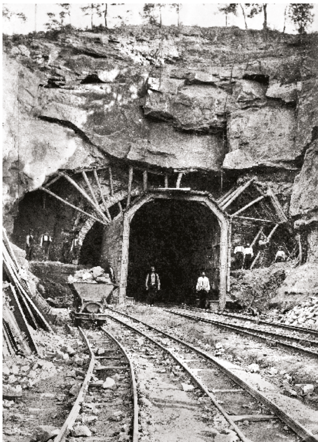
A la doble pàgina anterior, obres a la línia de la via única. En aquesta pàgina, entrada a un túnel de la línia Valls-Vilanova-Barcelona.
