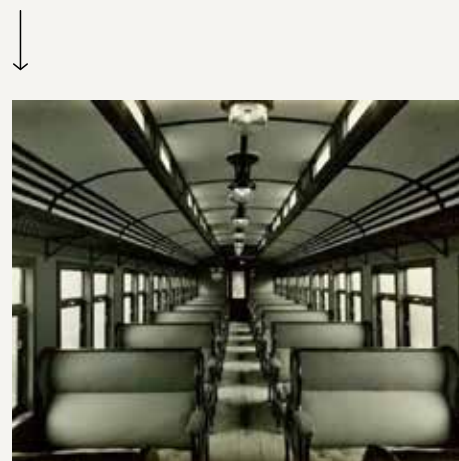
Fig. 9/ Cotxe de viatgers de segona classe amb enllumenat elèctric amb antigues làmpades de gas. Francesc Ribera Colomer. 1958.
