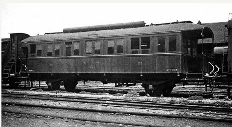
Fig. 12/ Cotxe de viatgers de tercera classe equipat amb un dipòsit de gas per a la il·luminació. Col·lecció Josep Miquel.
