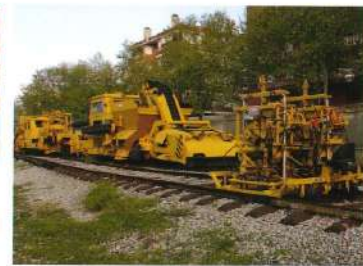
Maquinària de via 1960-70 COMSA 1. Batidora-anivelladora-aliniadora 2. Perfiladora 3. Batidora automàtica lleugera
