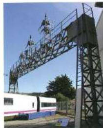
Pont de senyals de l'estació de Barcelona França 1929 General Railway Signal (GRS), (EUA)
