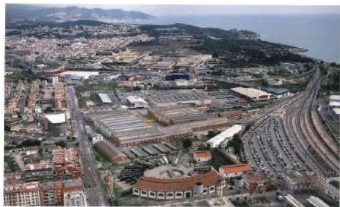
Instal·lacions del dipòsit de locomotores, taller de Renfe Intàgria i estació de Vilanova i la Geltrú, març de 2006.
