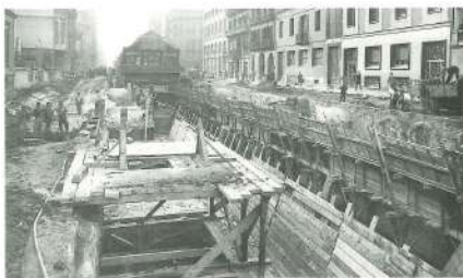
Baixador del Passeig de Gràcia. Obres de cobriment del carrer Aragó de Barcelona, en el sector comprès entre la Via Laietana i el carrer de Llíria. Any 1959
