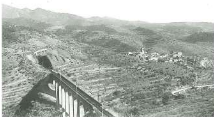
Vista panoràmica dels viaductes de Duesaigües, Els Masos i el poble de Duesaigües, en direcció a Riudocanys, després de l'electrificació. Línia de Madrid a Barcelona per Reus. Any 1958
