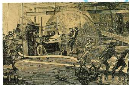
Fabricació de rails al taller de Creusot (França).
