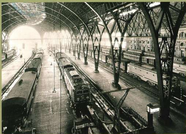
Vista de l'espectacular marquesina de l'Estació de França de Barcelona que va ser rehabilitada l'any 1922.
