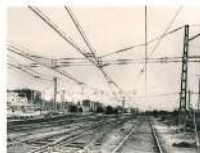
Entramat de línies elèctriques que configuren la catenària, d'on agafen corrent els trens.
