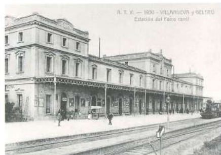
L'estació de Vilanova, l'any 1930. Malgrat les renovacions que s'han fet al llarg del temps, conserva el seu aspecte original, de 1881.
